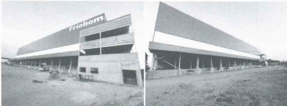
Casa de Bombas, Cisterna e Substação:
