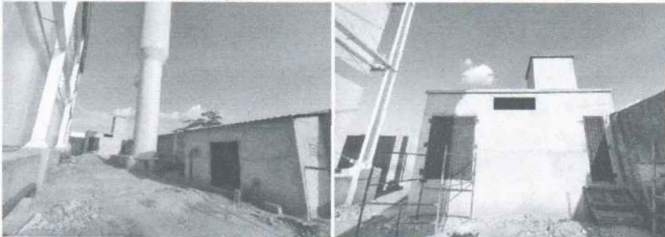
Fechento das Camaras Frias com Pannel PIR 150mm
